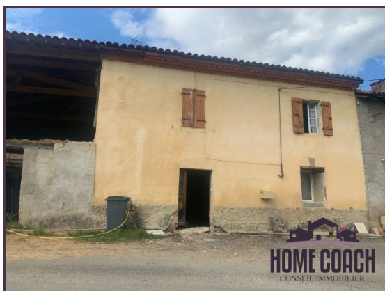
Maison 180 m 2 en cours de rénovation
